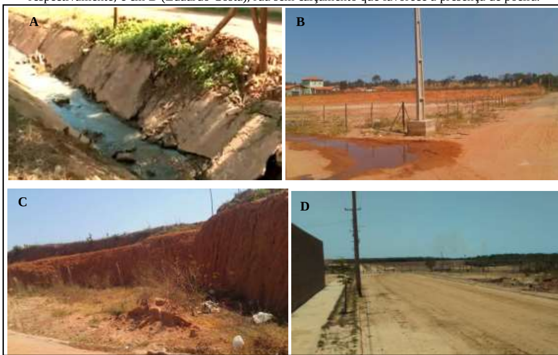
Figura 4 – Mosaico de fotos, em A (Porto Alegre), galeria projetada para transportar águas pluviais e que é utilizada como esgoto a céu aberto; em B e C (Torquato Neto), área sem utilização e pontos de lixo, respectivamente; e em D (Eduardo Costa), rua sem calçamento que favorece a presença de poeira.
