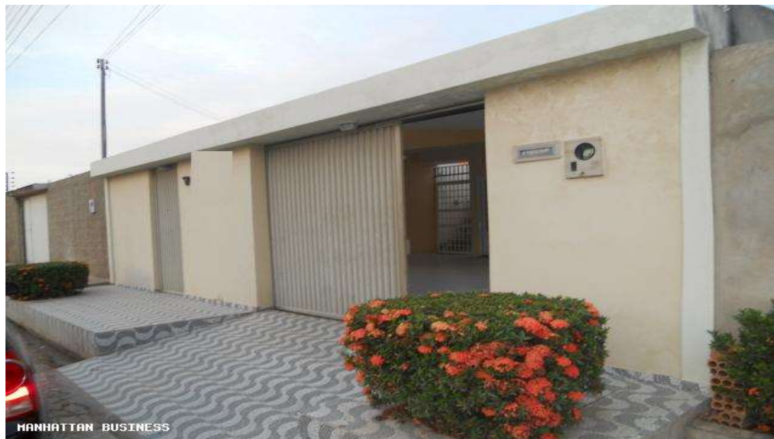
Figura 5 - Casa de luxo localizada no bairro Gurupi.
