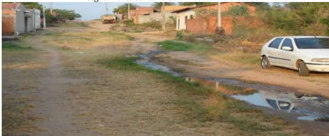
Figura 9 – Rua da vila Alto da Ressurreição sem calçamento e com problemas no esgotamento sanitário sem infraestrutura básica.
