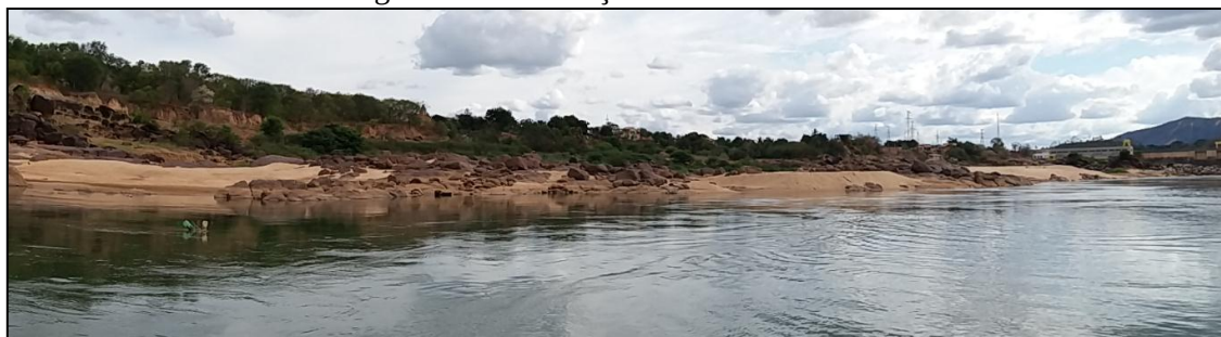
Figura 4 - Vista do barco, em primeiro plano, a área/ponto “8d” a extensa margem erodida e ao fundo da imagem a casa de forçada UHE de Mascarenhas.
