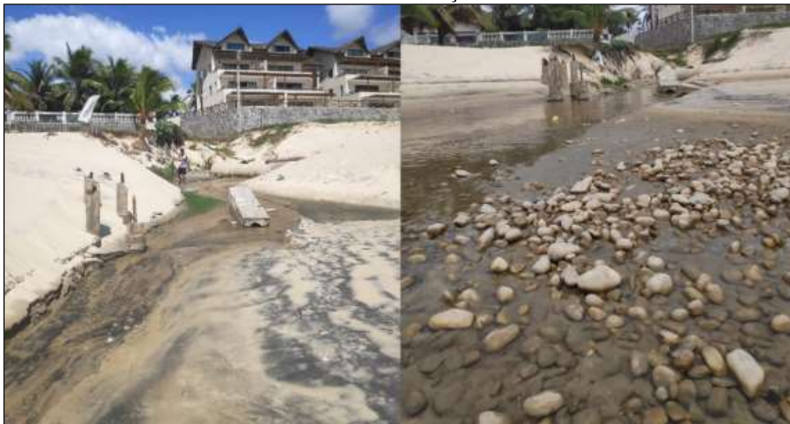
Figura 8 – Modificação da fisiografia praial em decorrência da exposição da galeria pluvial em concomitância a atuação das ondas
