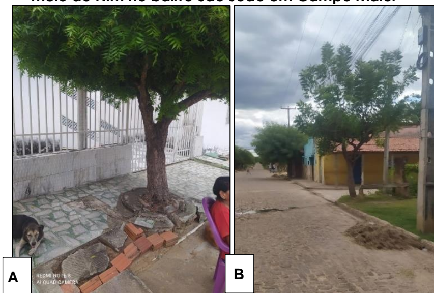
Figura 6 – Fotografias de destruição de calçadas e contato com fiação elétrica por meio do Nim no bairro São João em Campo Maior
