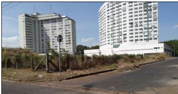
Figura 10 - Fotografia que mostra prédio comercial e terreno desocupado
