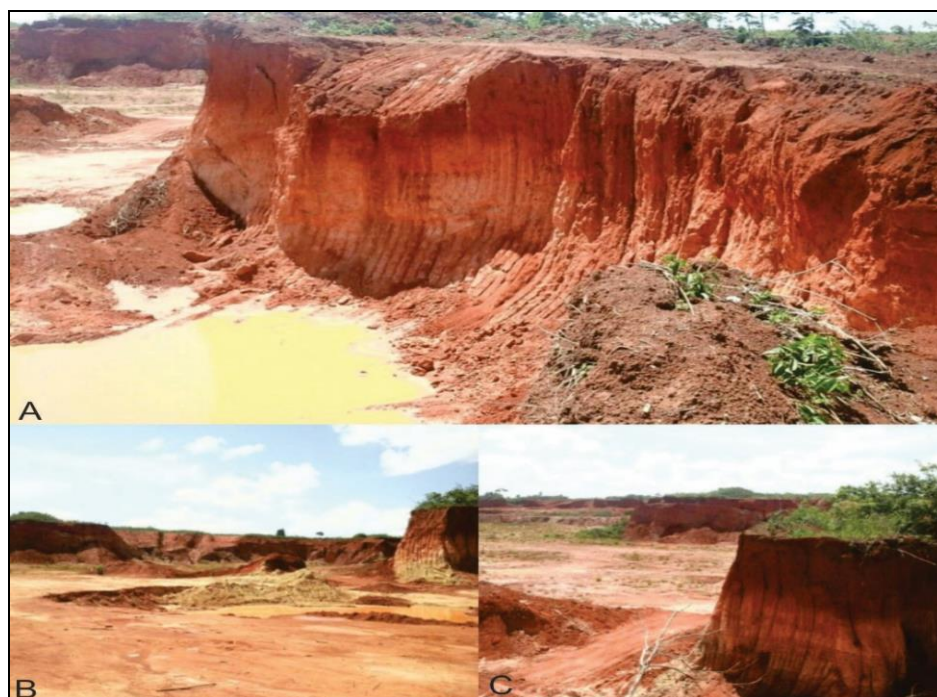
Figura 4 – Fotografia em mosaico da degradação do solo e afloramento do lençol freático em jazida de argila localizada no Povoado Jardim
